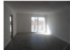
LAVORI INTERNI AI LOCALI
