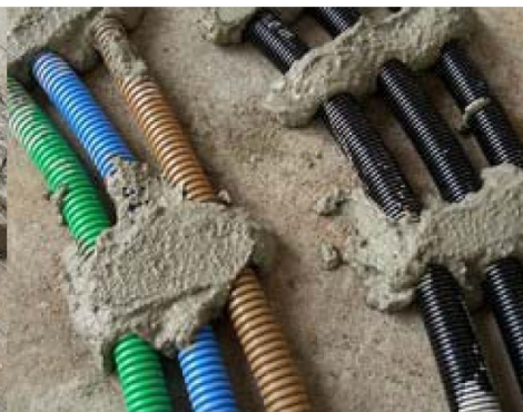
Figura 6.5c: distanziamento dei tubi per consentire l'inserimento fra di essi della colata del massetto
