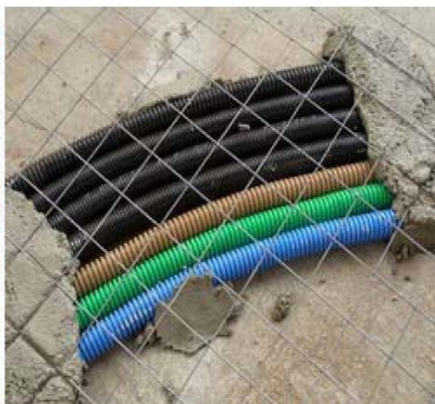
Figura 6.5b: protezione con rete elettrosaldata
