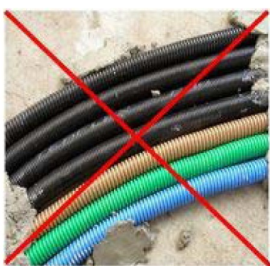
Figura 6.5a: posa errata
