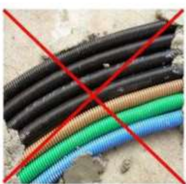
Figura 6.5a: posa errata
